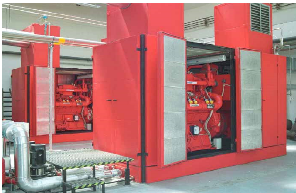
Obrázek: 5 Kogenerační jednotka na bioplyn TBG 520 firmy Motorgas (520 kWe, 725 kWt)
