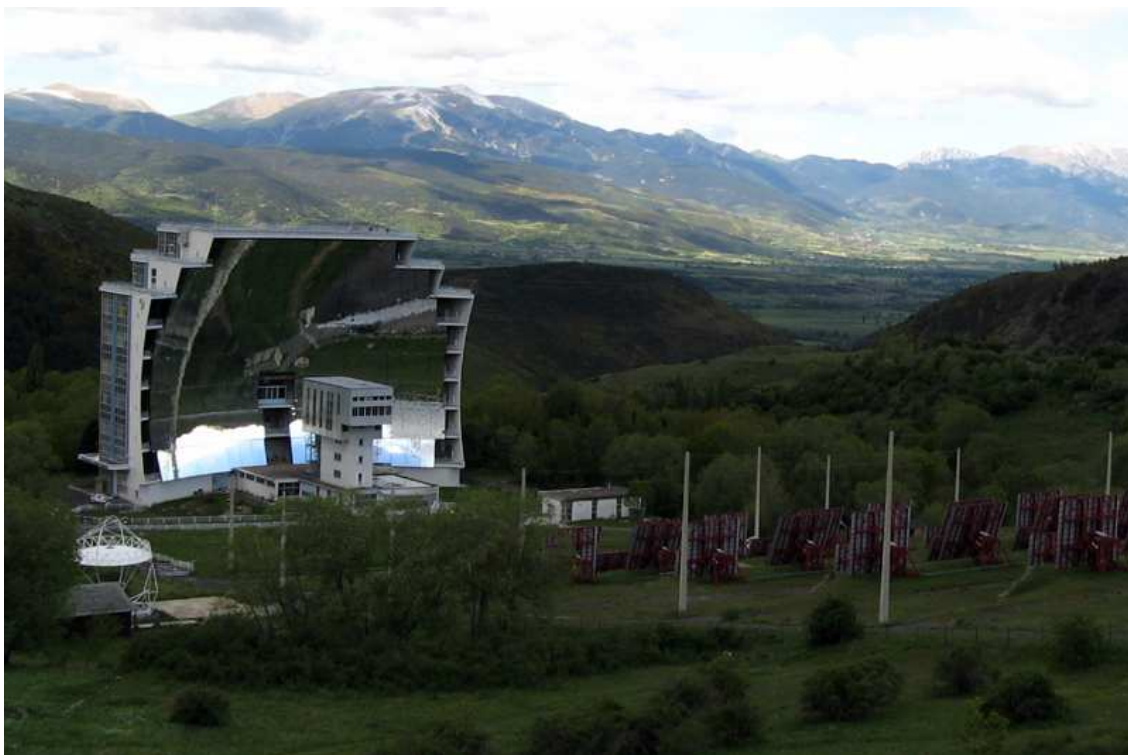
Obr. 2.4.: Odeillo Slubeční pec Odeillo (France) – tower solar plant
