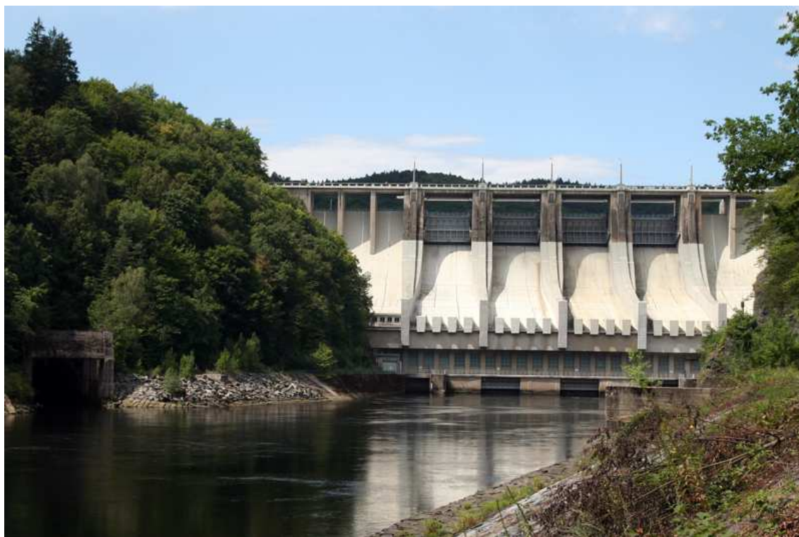
Obr. 1.1.: Vodní elektrárna Slapy
