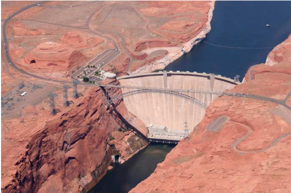
Obr. 1.3.: Betonová přehrada (Glen Canyon, Arizona)
