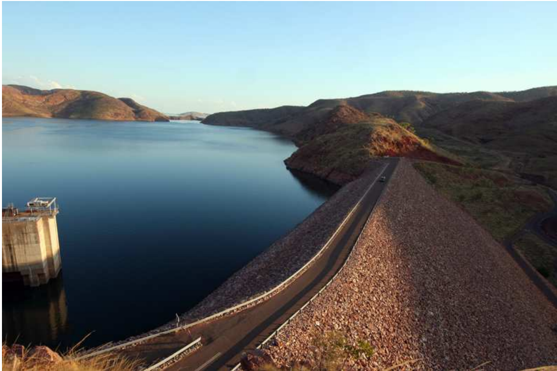
Obr. 1.2.: Gravitační přehrada (Lake Argyle, Western Australia)
