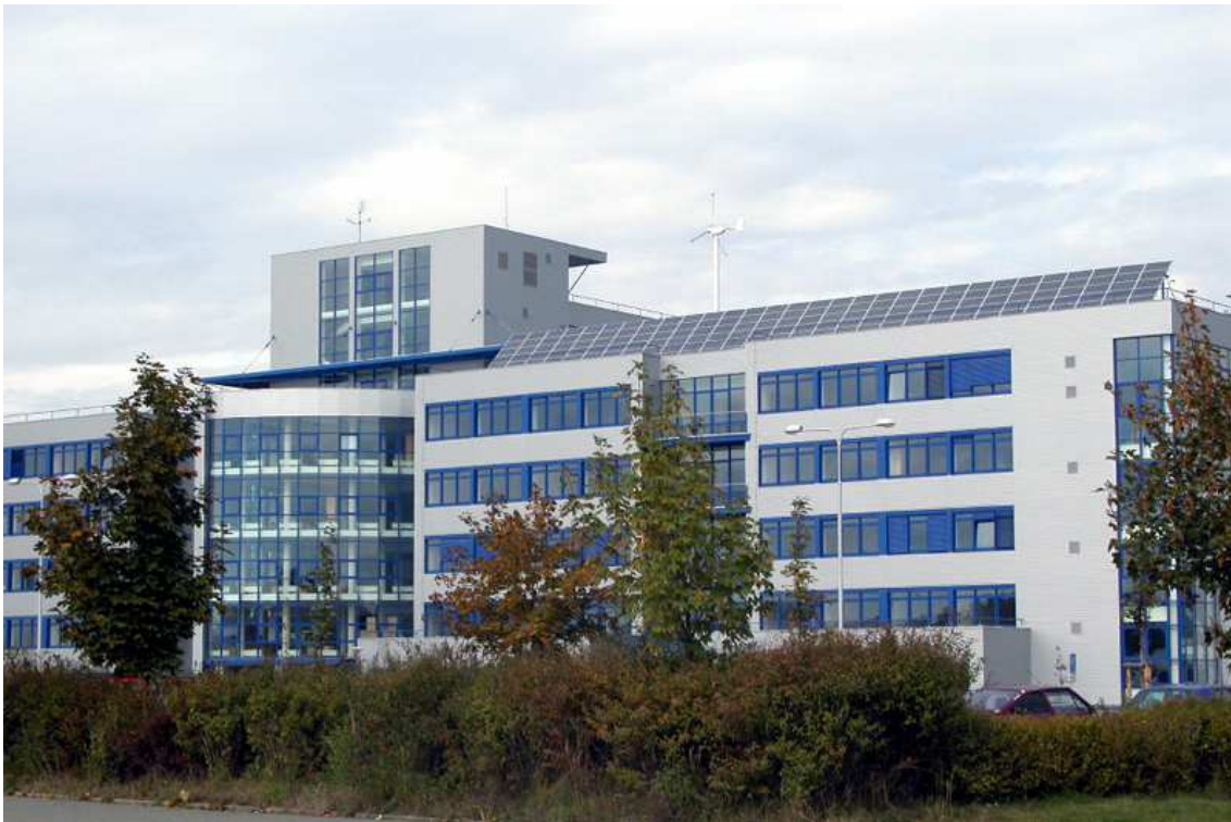
Obr. 1.15.: Fotovoltaická elektrárna Západočeské univerzity v Plzni
